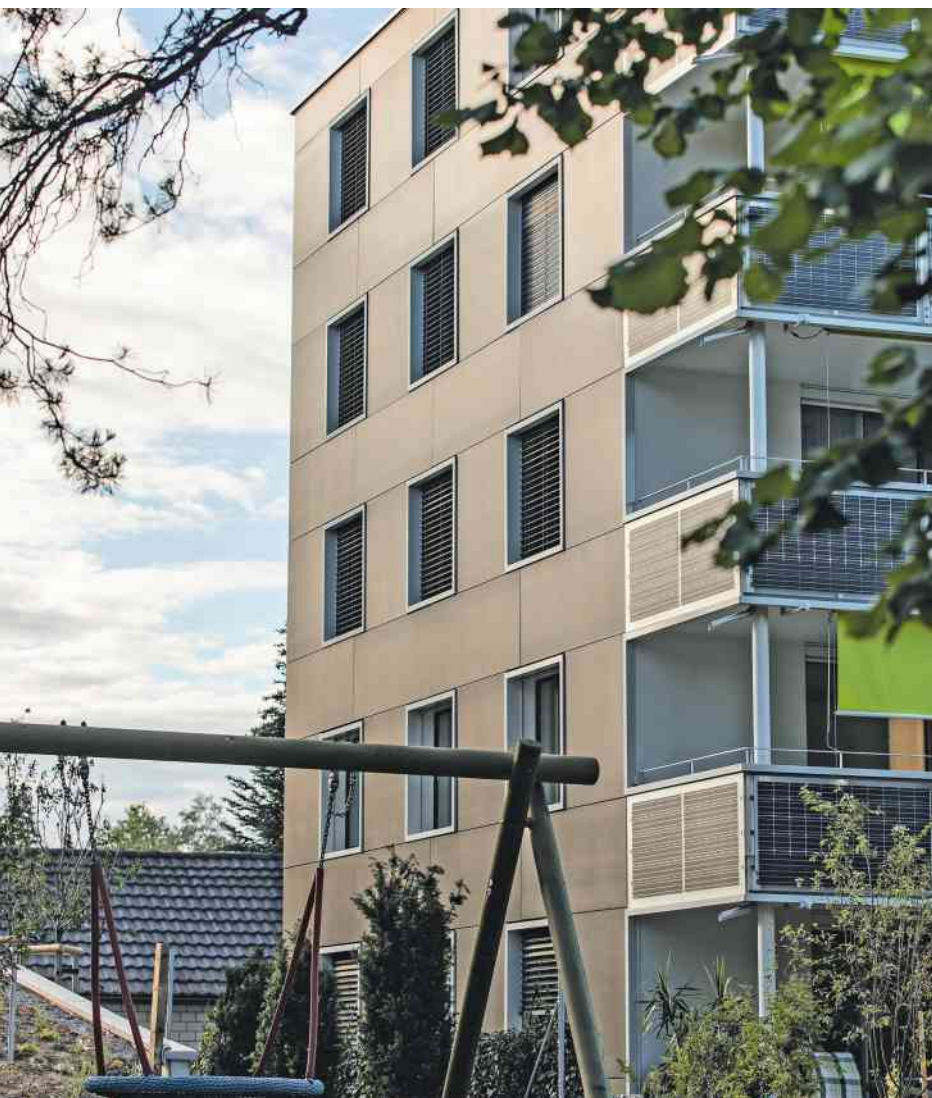
Auf dem Dach, an der Fassade und an den Balkonbrüstungen des SonnenparkPLUS produzieren insgesamt 495 m 2 monokristalline PV-Zellen etwa 68 000 kWh Strom pro Jahr. Das MFH wurde mit dem PlusEnergieBau-Solarpreis 2018 ausgezeichnet. (Bilder: Arento AG)
